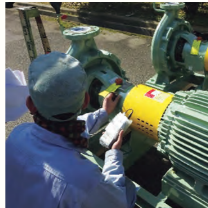
渦巻きポンプ 点検修理
