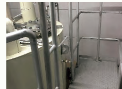
タンク上部作業用歩廊
