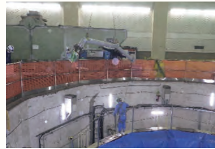
リング管補修工事
