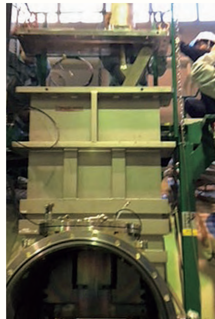
大口径ゲート弁修理
